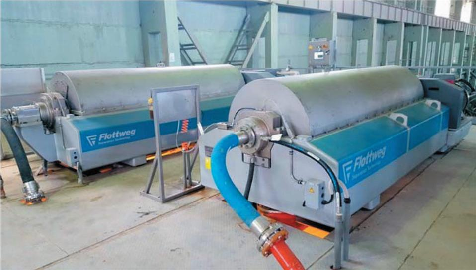
**Рисунок 2.** Комплекс по обезвоживанию осадка шахтных и подотвальных вод Учалинского ГОК
